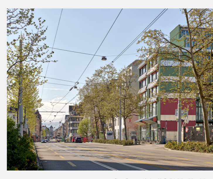
Straßenansicht // © Philip Heckhausen
