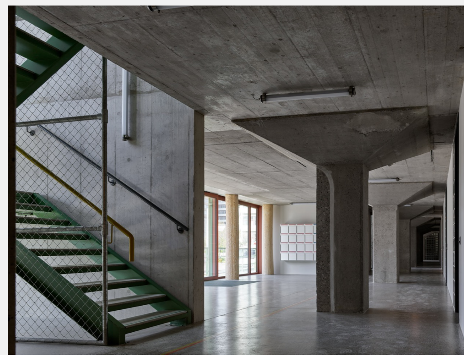
Die Pilzstützen wirken als sichtbare und erlebbare Gestaltungselemente. // © Philip Heckhausen
