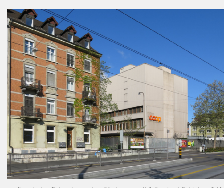
So sah das Gebäude vor dem Umbau aus. // © Raphael Schicker, Stiftung Habitat
