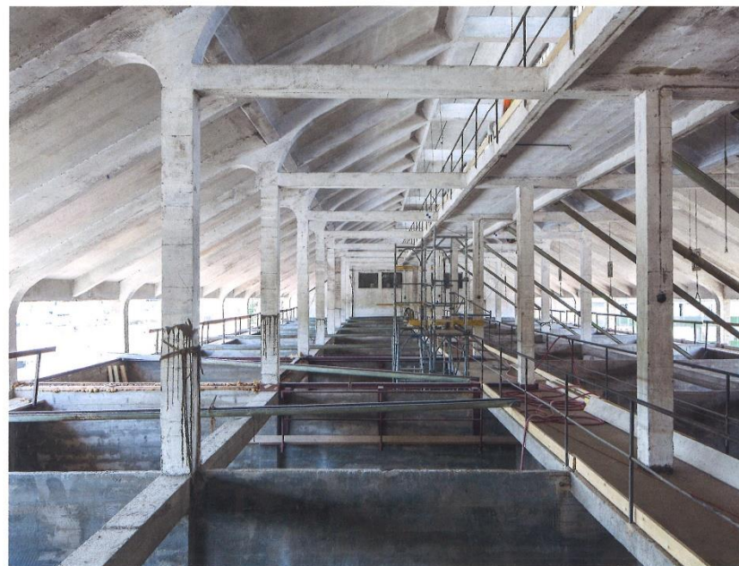
Das Dachgeschoss des Silogebäudes Erlenmatt mit den Betonelementen, die an Holzbauweise erinnern.
