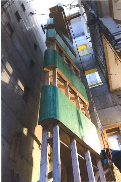
Schalungsarbeiten an einem der neuen Erschliessungskerne.
