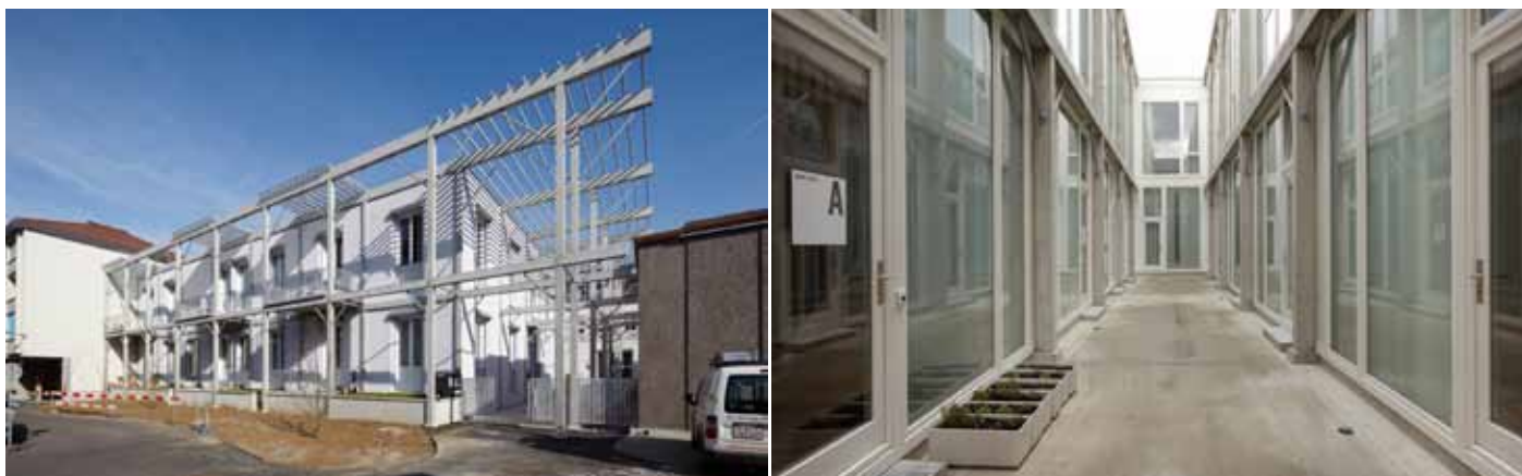
Die Betonelemente an der Fassade der einstigen Lagerhalle (links). Ein neuer Innenhof, der die Wohnungen in der Lagerhalle belichtet (rechts).
