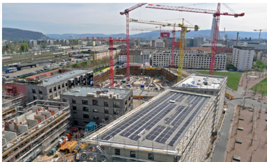
Auf den Dächern der Gebäude in Erlenmatt Ost werden Photovoltaik-Anlagen montiert. Damit wird rund die Hälfte des benötigten Stroms selbst gewonnen.
