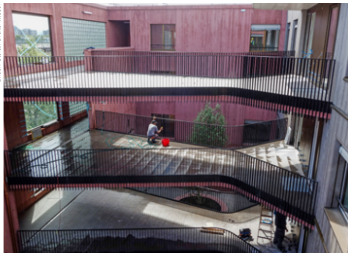
Die Luft- und Lichthöfe bilden nicht nur einen Schallschutz zur Signalstrasse hin, sondern sorgen auch dafür, dass manuell gelüftet werden kann.
