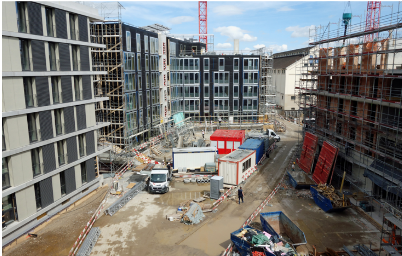
Noch sind die Bauarbeiten in vollem Gange, aber in diesem Innenhof sollen sich dereinst die Bewohner treffen und so zu einem lebendigen Quartier beitragen.
