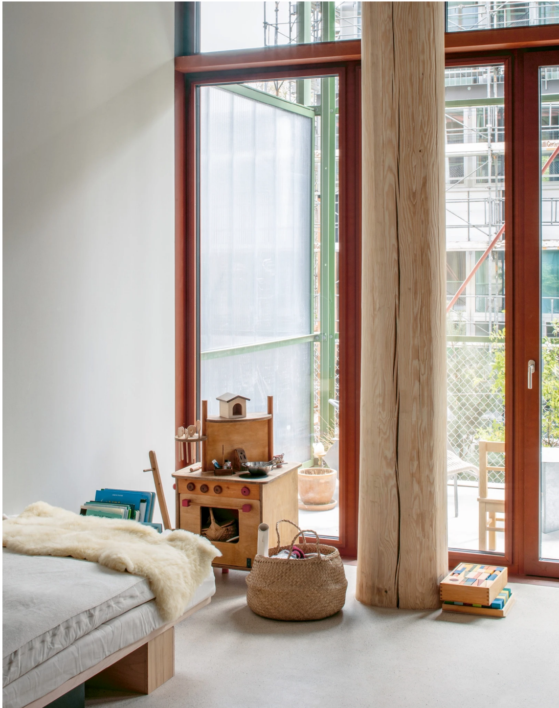
Die Rundholzstützen vor der Fassade verweisen auf den Bauprozess.
