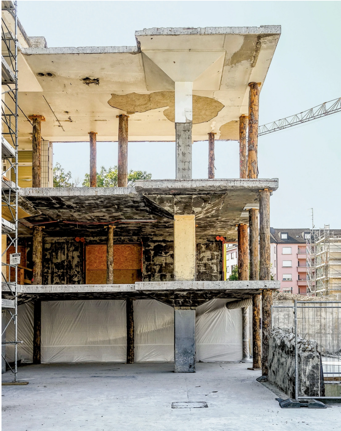
Die Geschosse wurden durch Holzstützen temporär abgestützt.
