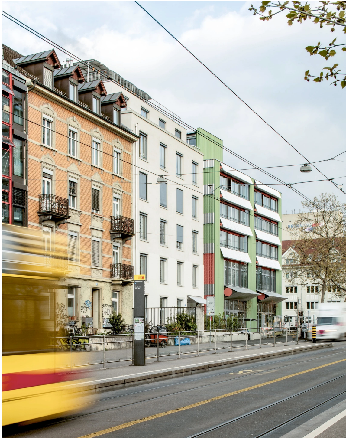
Die Stirnfassade führt die Häuserreihe an der Elsässerstrasse weiter.
